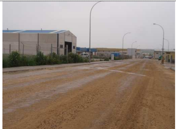
Acerados de la fase anterior. Polígono Industrial Ituci. Escacena del Campo
