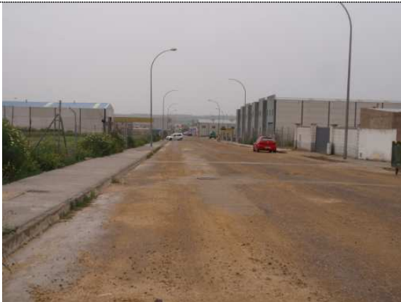
Encuentro de la fase anterior. Polígono Industrial Ituci. Escacena del Camp
